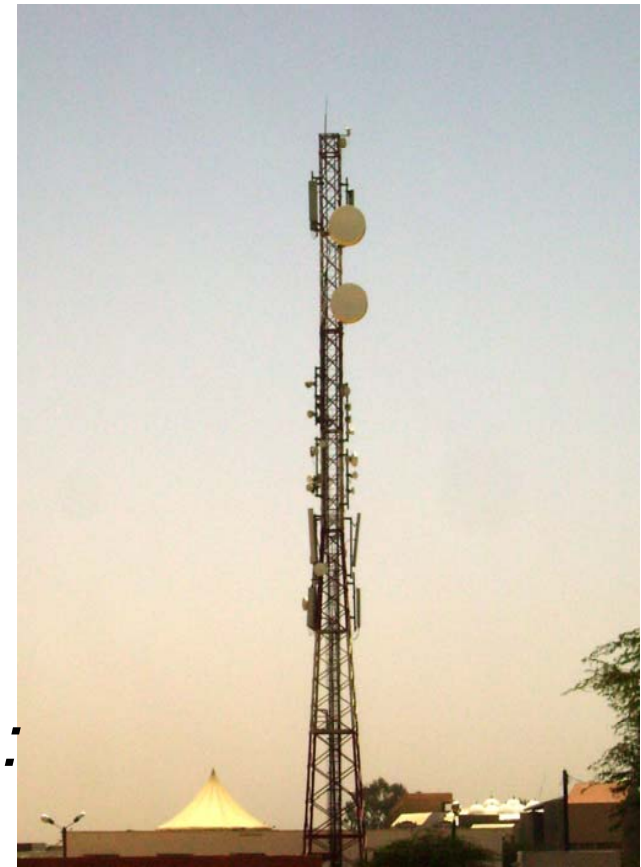
Pylône partagé, Nouakchott (capitale de la Mauritanie)
